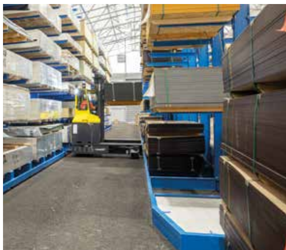
Ulokehyllyjen jalkapalkkeihin asennettiin ohjaukskot ja hyllyjen pätyihin ohjaukskaaret.
