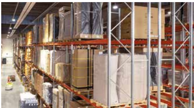
Huonekalulavojen hyllyt toteutettiin ns. 3-pylväselementillä, jolloin hyllyn etuosassa voidaan tarvittaessa varastoida myös standardimittaisia EUR- ja FIN-lavoja.
